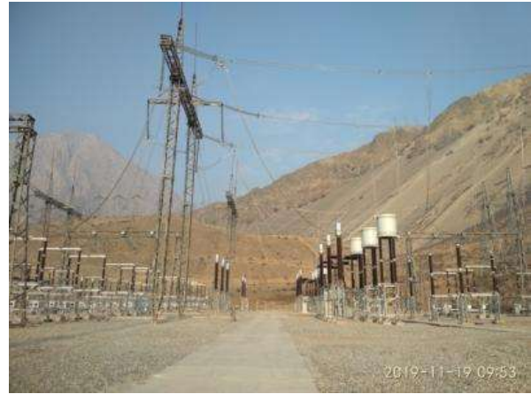
Рисунок 21. Подстанция 500 кВ после восстановительных работ (статус в ноябре 2019 г.)
