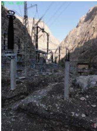
Рисунок 18. Завершающие работы по электрическому заземлению в пункте перехода (Статус в октябре 2019 г.)
