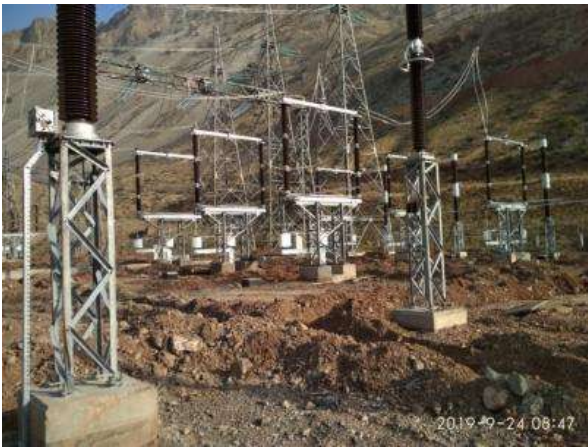
Рисунок 10. Работы по проводу заземления (Статус в сентябре 2019 г.)
