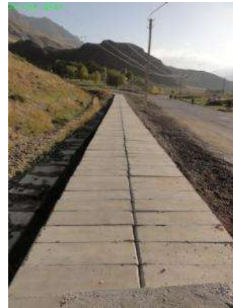
Рисунок 13. Новый кабельный лоток между туннелем и площадкой распреустройства (Статус в октябре 2019 г.)
