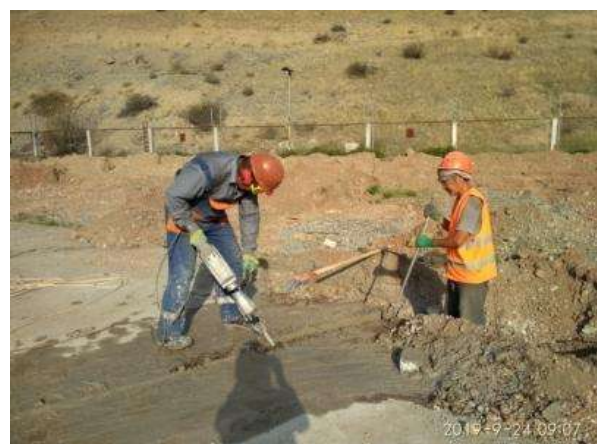
Рисунок 33. Защитные наушники используются работником при работе с перфоратором (статус в сентябре 2019 г.)
