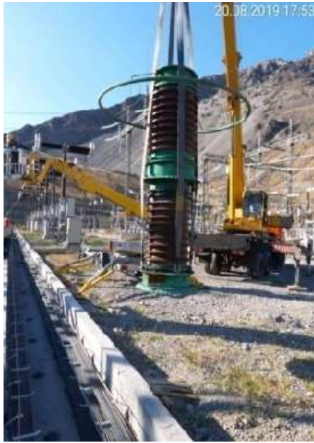
Рисунок 6. Работы по демонтажу старого электрооборудования (Статус в августе 2019г.)
