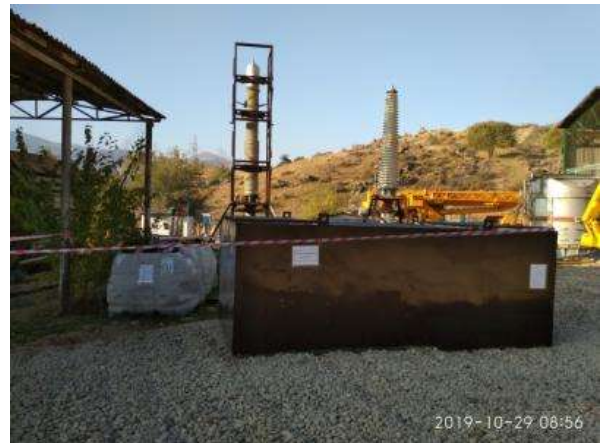
Рисунок 19. Новый контейнер для временного хранения асбестосодержащих материалов (Статус в октябре 2019 г.)
