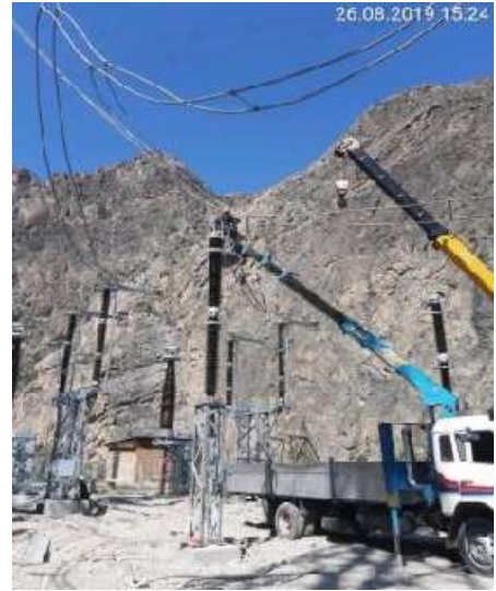
Рисунок 7. Верхолазная работа на подстанции 500 кВ Токтогульской ГЭС (Статус в августе 2019 г.)
