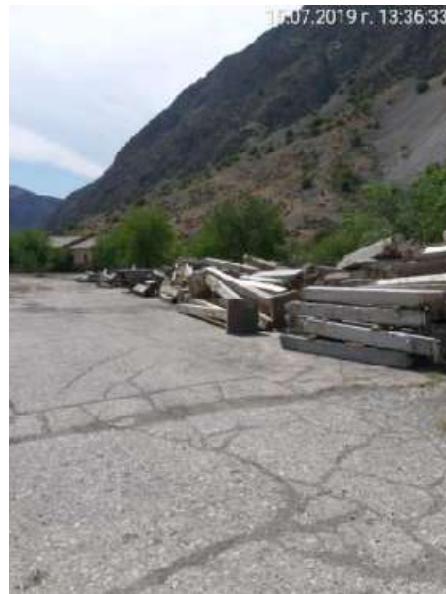
Рисунок 25. Бетонные строительные отходы вывезены с площадки на склад хранения Токтогульской ГЭС (Статус в августе 2019 г.)
