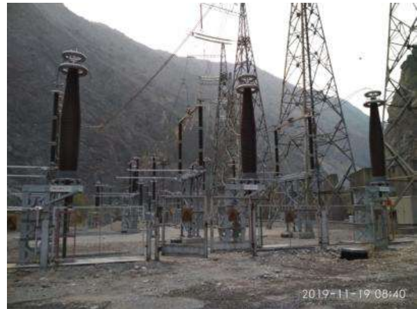
Рисунок 23. Пункт перехода 500 кВ после восстановительных работ (статус в ноябре 2019 г.)
