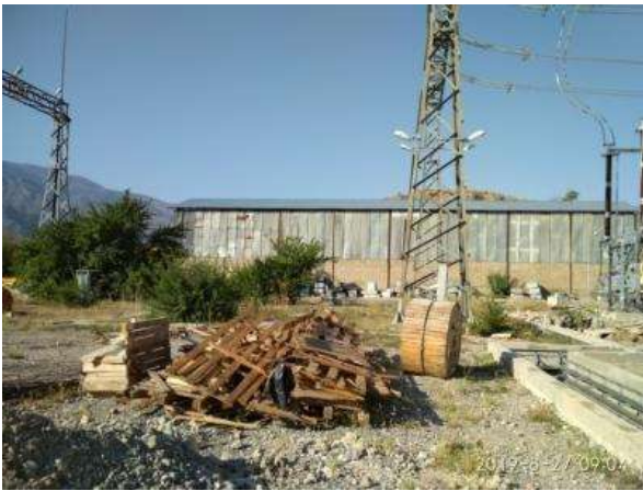
Рисунок 24. Деревянные строительные отходы временно хранятся на площадке (Статус в августе 2019 г.)
