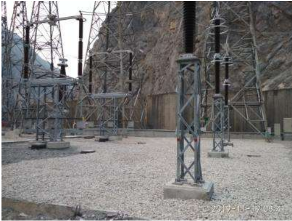
Рисунок 20. Пункт перекидки 500 кВ после покрытия гравием (Статус в ноябре 2019 г.)
