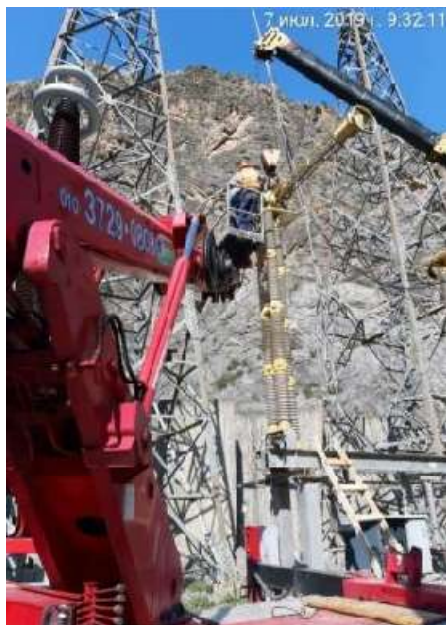
Рисунок 4. Верхолазная работа на подстанции 500 кВ Токтогульской ГЭС (Статус в июле 2019 г.)
