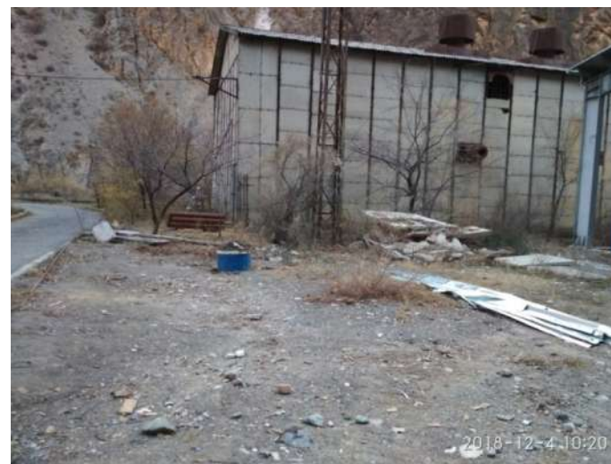
Фото 4. Участок размещения строительных материалов и отходов подрядчика
