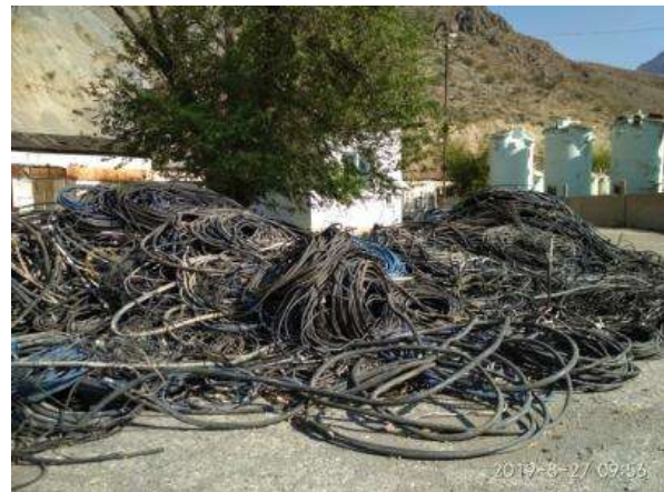
Рисунок 27. Демонтированные кабели были вывезены с площадки на склад хранения Каскада Токтогульских ГЭС (Статус в августе 2019 г.)
