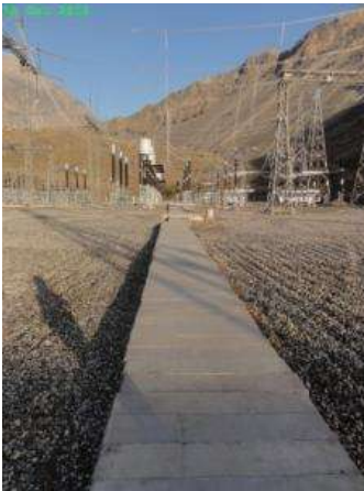
Рисунок 12. Новый кабельный лоток на площадке распреустройства (Статус в октябре 2019 г.)
