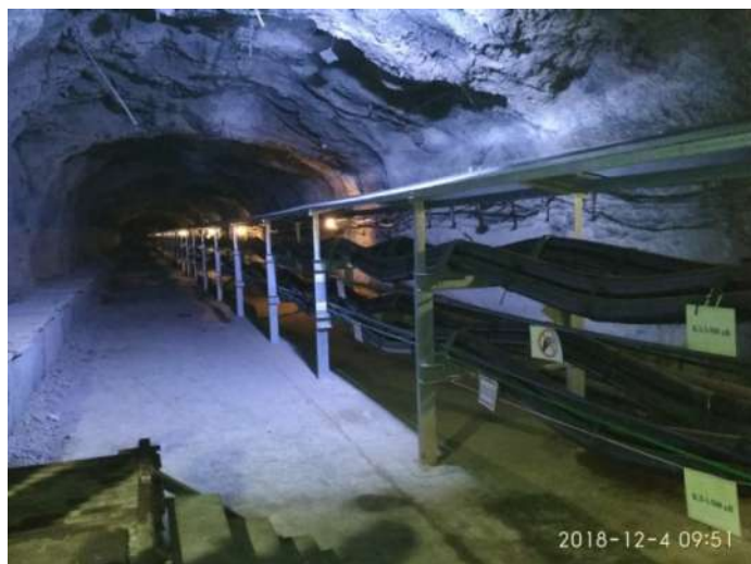
Фото 1. Участок кабельного туннеля 500 кВ. Токтогульской ГЭС
