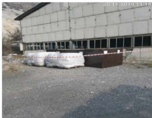
Фото 3. Контейнеры с асбестосодержащими отходами расположены на площадке хранения Заказчика/КТГЭС (Статус - ноябрь 2019г.)
