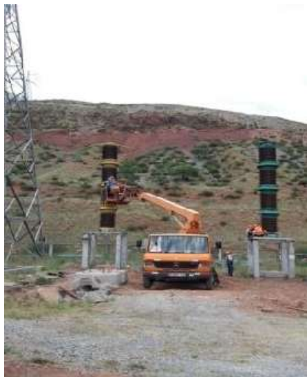
Рисунок 2. Демонтажные работы на подстанции 500 кВ Токтогульской ГЭС (Статус в июле 2019 г.)
