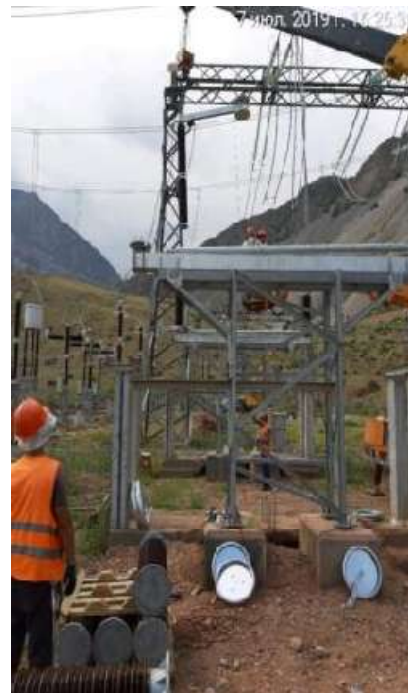
Рисунок 3. Монтаж металлического оборудования на подстанции 500 кВ Токтогульской ГЭС (Статус в июле 2019 г.)
