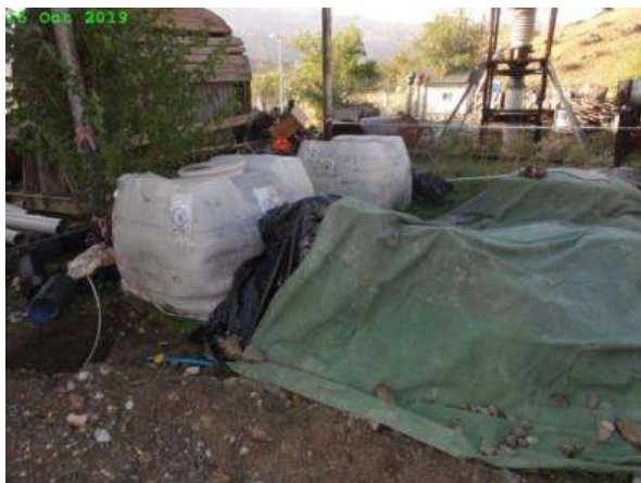
Рисунок 14. Временное хранение асбестосодержащих отходов (Статус в октябре 2019 г.)
