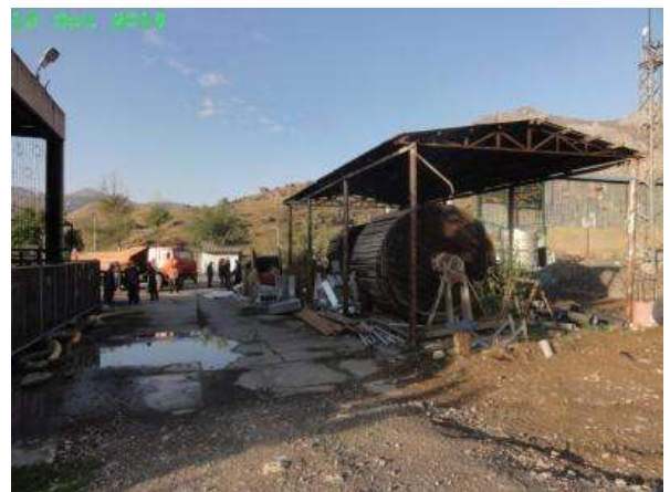
Рисунок 15. Остатки отходов на площадке распреустройства (Статус в октябре 2019 г.)
