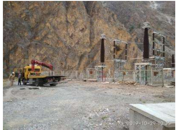
Рисунок 17. Работы по подготовке к гравийному покрытию в точке перехода 500 кВ (Статус в октябре 2019г.)
