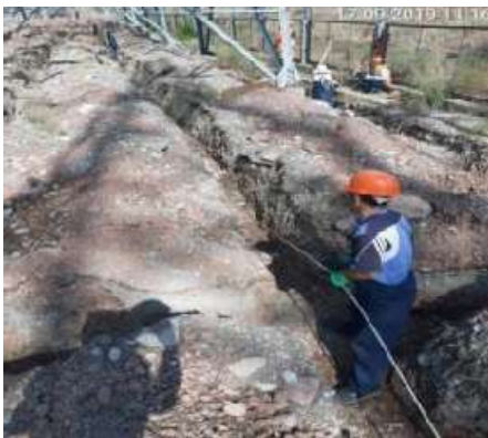
Рисунок 8. Монтаж заземляющего проводника (Статус в сентябре 2019 г.)
