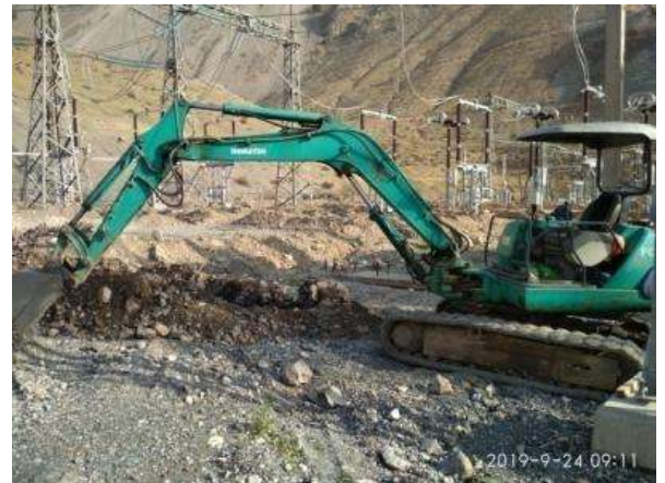
Рисунок 9. Земляные работы на подстанции 500 кВ (Статус в сентябре 2019 г.)
