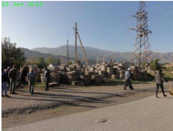
Рисунок 16. Временное хранение старых лотков кабельных каналов (Статус в октябре 2019 г.)
