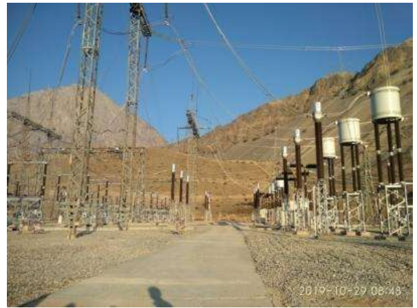
Рисунок 11. Чистая площадка распреустройства, большинство работ завершено (Статус в октябре 2019 г.)
