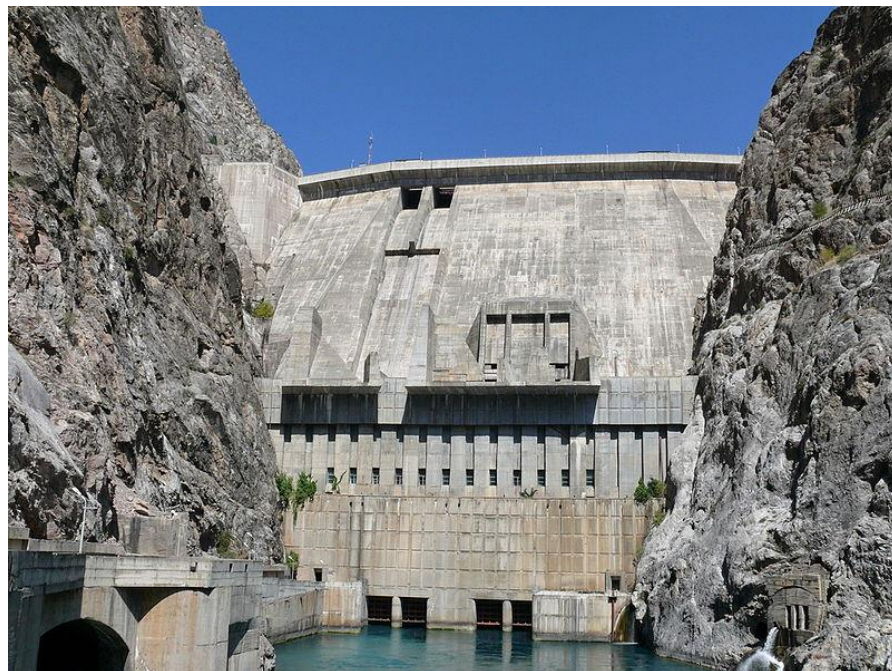
Рис.1. Плотина Токтогульской ГЭС
