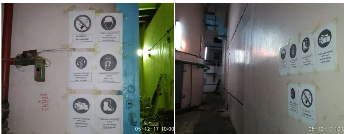
Рисунок 14. Предупредительные знаки и таблички с инструкциями внутри Токтогульской ГЭС строительного подрядчика «ЮС» - статус на сентябрь 2017 года.
