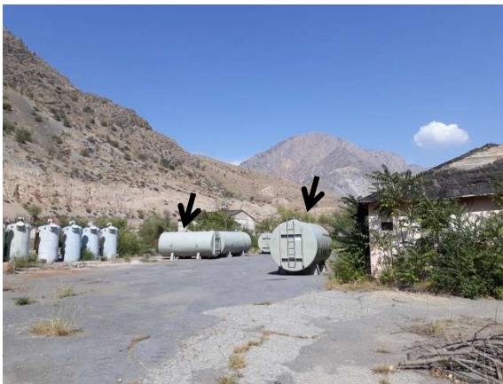
Рисунок 18. Резервуары для хранения старого трансформаторного масла в огороженном хранилище Токтогульской ГЭС - статус на сентябрь 2017 года.
