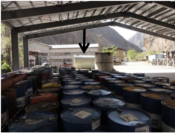
Рисунок 17. Емкость для трансформаторного масла из главного трансформатора Т2 (черная стрелка). Кабельное масло Агрегата 2 хранится в синих бочках - статус на сентябрь 2017 года.
