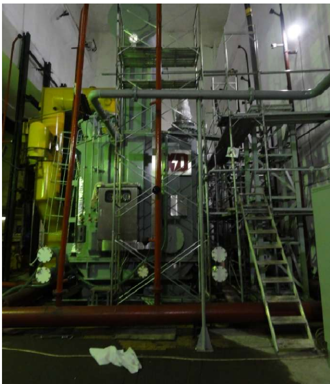
Рисунок 4. Новый установленный главный трансформатор T2 - Статус на декабрь 2017 года.
