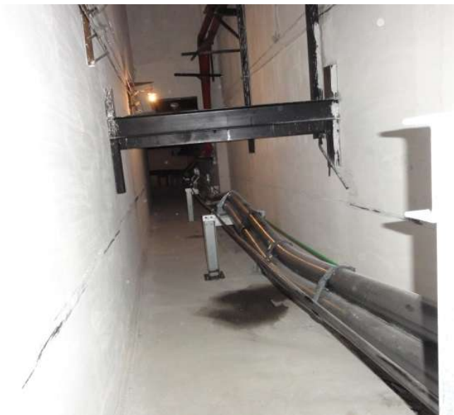
Рисунок 6. Новые кабели 500 кВ Агрегата 2 - Статус на декабрь 2017 года.
