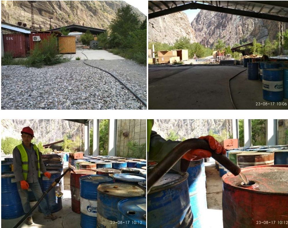
Рисунок 10. Слив масла кабельной линии 500 кВ Агрегата 2 Токтогульской ГЭС. Использование шланга для слива кабельного масла в бочку.
