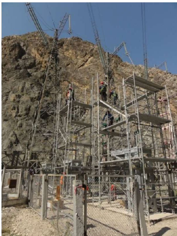
Рисунок 15. Работа на высоте на распредустройстве НН - статус на сентябрь 2017г.
