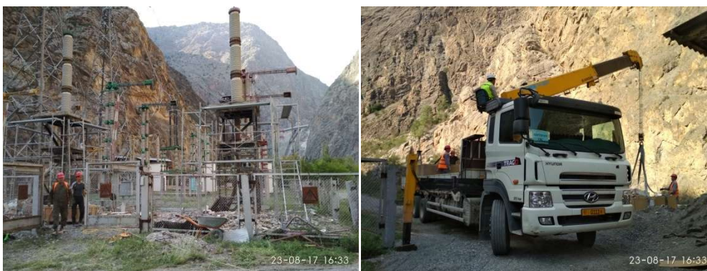
Рисунок 11. Разбор кирпичной кладки на пункте перекидки Токтогульской ГЭС и использованная тяжелая техника.
