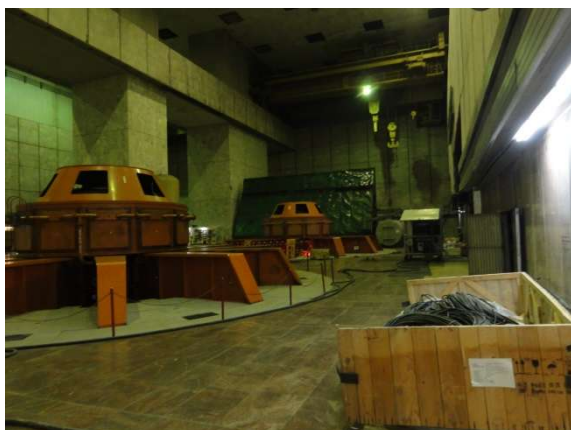
Рисунок 25. Чистая строительная площадка на электростанции Токтогульской ГЭС - статус на декабрь 2017 года.
