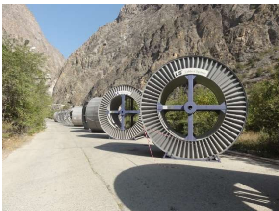
Рисунок 3. Кабельные барабаны для доставки кабеля 500 кВ - Статус на сентябрь 2017 года.
